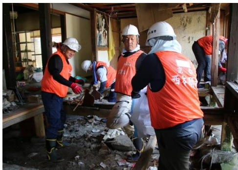
海水に浸かった床板を外し、流入物を撤去していく
